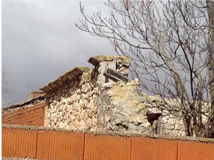
Pedazo de hastial principal trasero con terminación del alero del tejado; ambos originales
